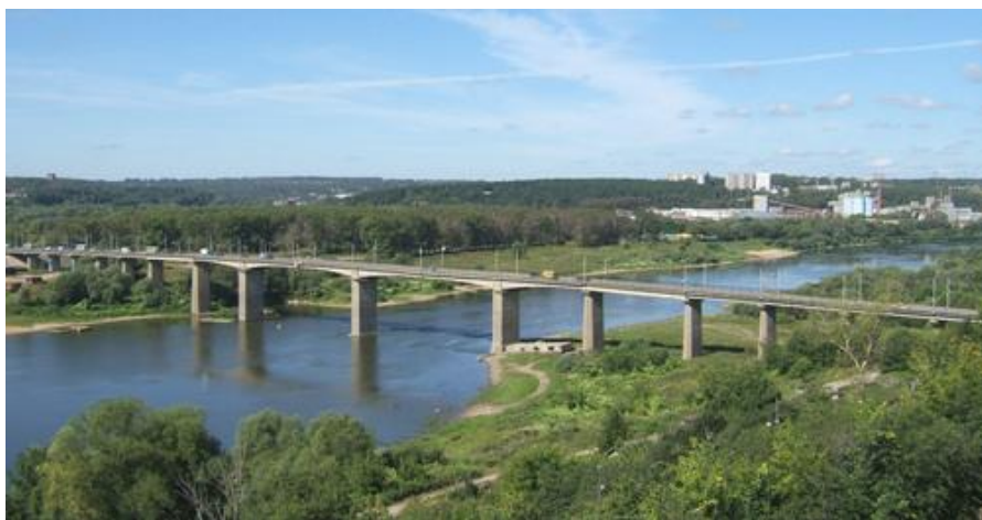
Алексин. Мост через Оку (Google Earth)
